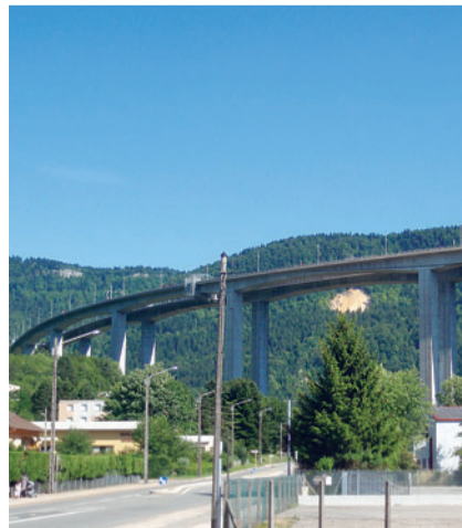
Zu dieser Autobahnbrücke bei Nantua in Frankreich lieferte Mageba Fahrbahnübergänge diverser Grössen.
