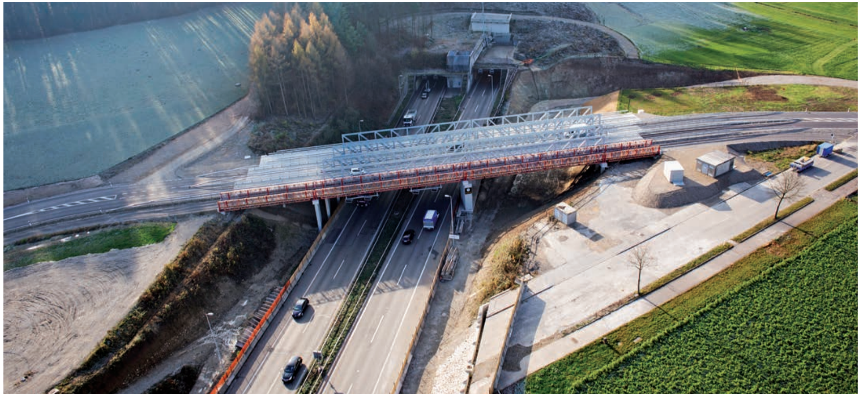
Die Bülacher Industrien bauen Brücken: Die Firma Baltensperger AG realisierte beim Gubristunnel sechs Hilfsbrücken aus einer Stahl-Fachwerkkonstruktion.
