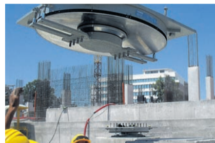
Einbau eines Erdbebenlagers von Mageba im Stavros Niachros Cultural Center in Athen
