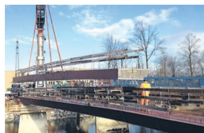
Die Rathausenbrücke in Emmen, erstellt von Baltensperger AG
