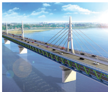
Die dritte Zhengzhou-Brücke in der chinesischen Metropole Zhengzhou wird mit 6 mageba TENSA®MODULAR Dehnfügen vom Typ LR8 ausgerüstet
